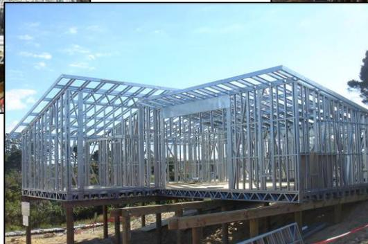
Die Beplankung von Stahlleichtbaukonstruktionen mit Rigidur H, Ridurit (Glasroc F), „Die Dicke“ oder mit der Rigips Feuerschutzplatte RF kann entsprechend der folgenden Prinzipskizzen erfolgen. Natürlich können nicht nur Innenwände mit Rigips Platten beplankt werden, sondern auch Gebäudeabschlusswände, sofern für einen ausreichenden Wetterschutz gesorgt ist.
