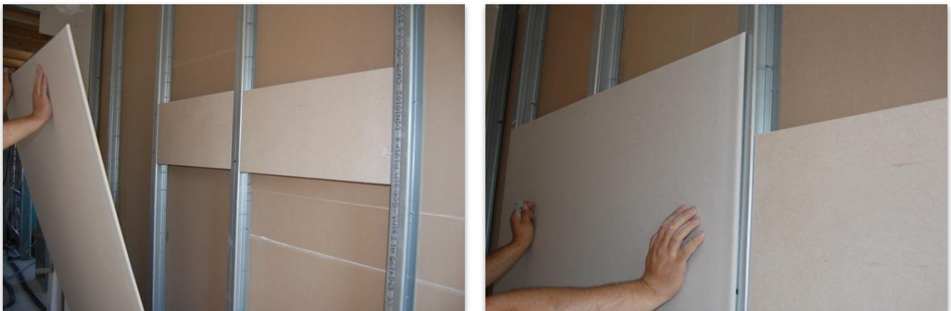
Bild 7: Ansetzen der ersten Beplankungslage
