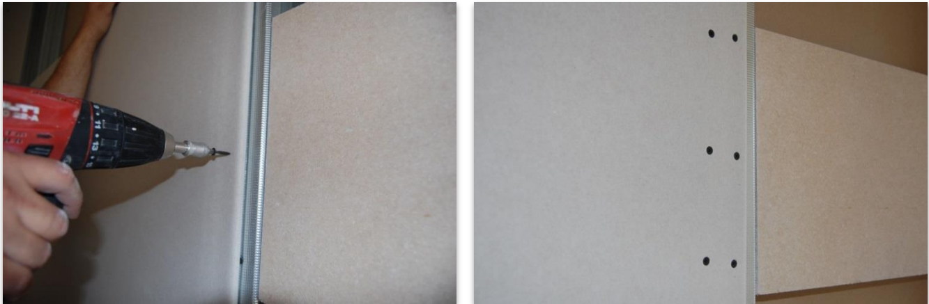
Bild 8: Befestigung der Rigips Traverse mit der Beplankung und der Beplankung mit dem CW Profil
