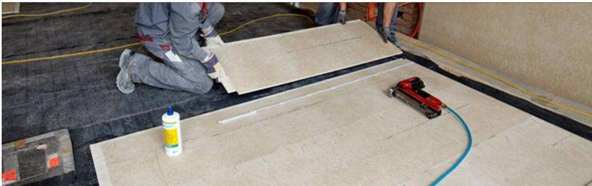
**Abbildung 12: Verlegung von Rigidur Estrichelementen**
