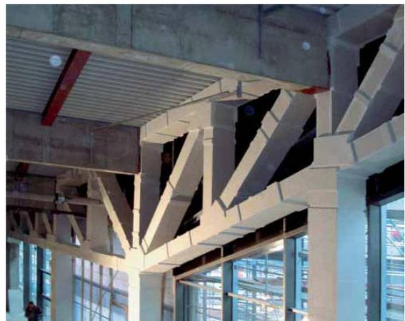
**Abbildung 11: Stützen- und Trägerbekleidung**
